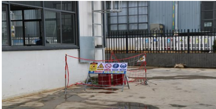
进入屋顶入口设置的警戒线和安全警示标志
